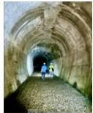
(写真4) 山守隧道
